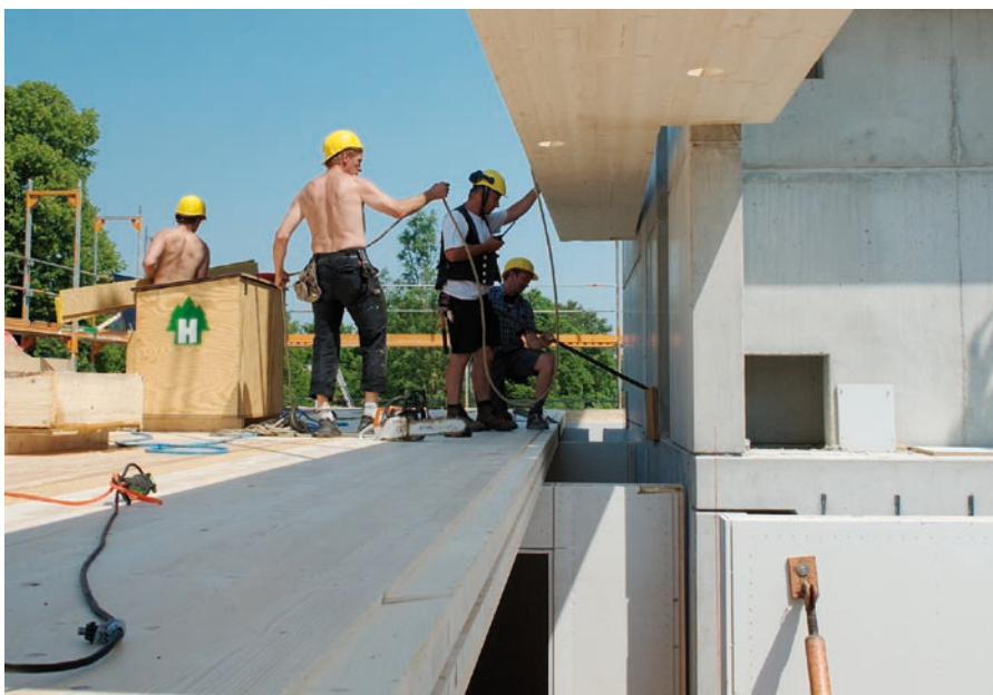
Die Deckenelemente sind aus Brettspertholz. Die Auflagerbereiche wurden mit Bohrungen versehen, die mit Beton vergossen wurden. Somit ruhen die tragenden Wände auf setzungsunempfindlichen Betonpolstern.
