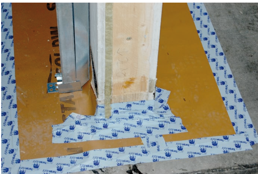
Alle Anschlüsse und Durchdringungen in den Decken wurden rauchdicht ausgebildet. Im Falle eines Feuers kann der Rauch, vom dem bei einem Brand eine viel höhere Gefahr ausgeht als vom Feuer, nicht in die anderen Geschosse gelangen.
